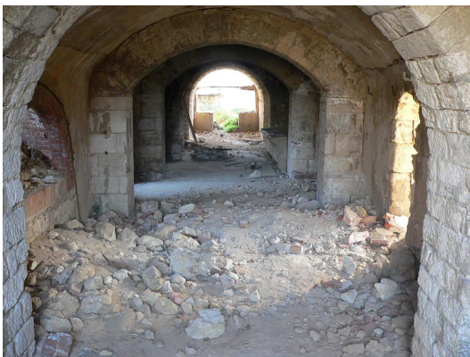
Photo 9 : Avant nettoyage et mise en sécurité
