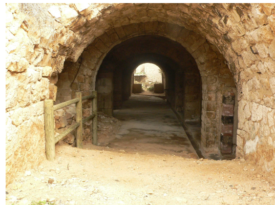
Photo 10 : Après nettoyage et mise en sécurité
